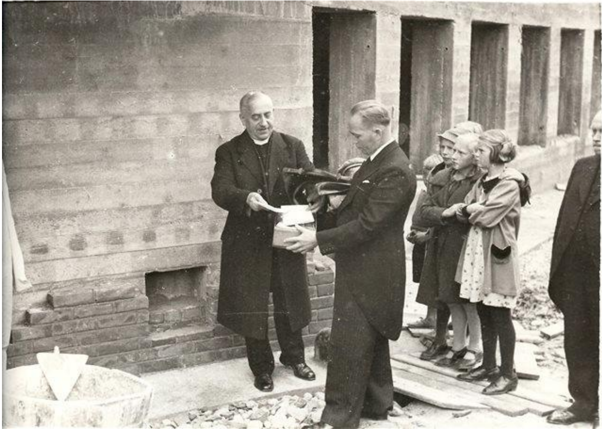
Fra grunnsteinsnedleggelsen 21. september 1937
